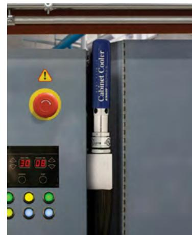
Seitliche Anbringung eines Schaltschrankkühlers mit Hilfe des seitlichen Befestigungssets.
