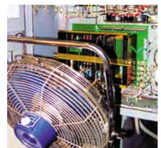
Es besteht eine hohe Schockgefahr, wenn die Schalttafel geöffnet wird und ein Ventilator heiße, schmutzige Fabrikluft auf die Elektronik bläst.
