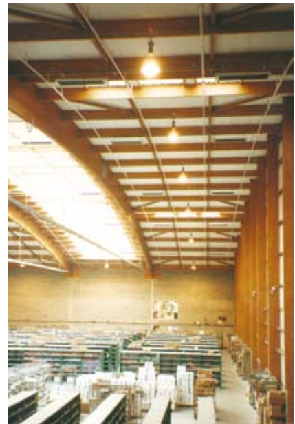
Wärmestrahler eignen sich besonders für Räume mit hohen Decken, da es zu keinem Wärmeverlust zwischen Wärmestrahler und Fußboden kommt.
