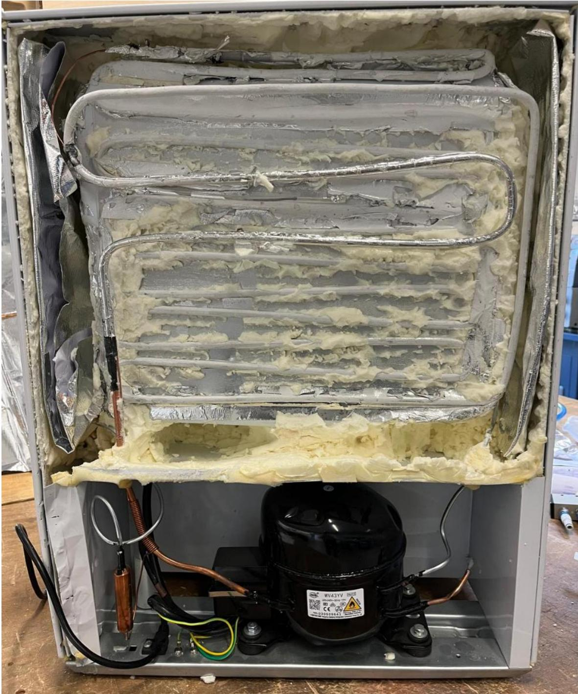
Abbildung 12: Freigelegte Kühlmittelrohre auf Kühlschrank-Rückseite
