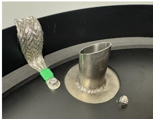
Abb 4: Befestigung des Erdungsbandes an der Unterseite des Fassdeckels
